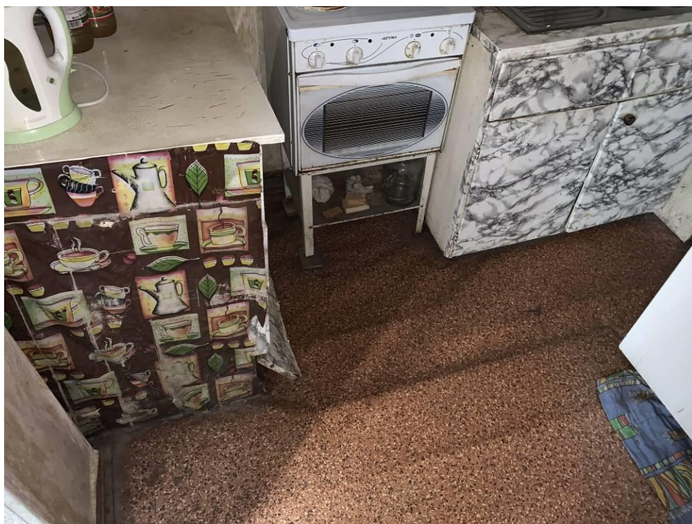
Фото 76. В квартире №1 в пом. Кухня провал пола
