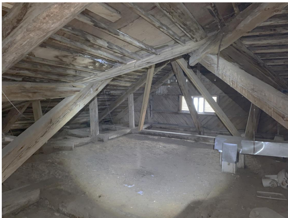
Фото 1.3.5.2 Общий вид конструкций стропильной системы
