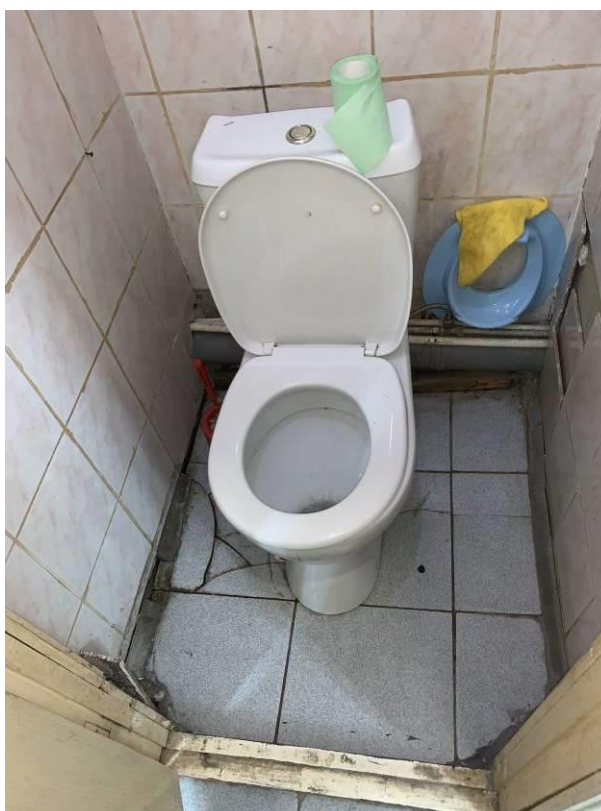
Фото 80. Уклон и растрескивание плитки полов в с/у в осях 4-7/И-К 2- го этажа
