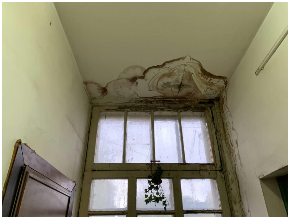
Фото 45. Перекрытие коридора в осях К/3-4
