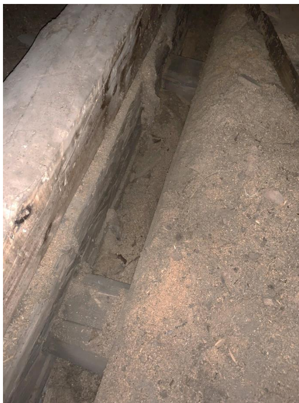
Фото 1.3.4.5. Конструкция чердачного перекрытия в месте вскрытия №6
