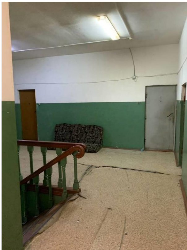
Фото 84. Истертость покрытия полов в общем коридоре 2-го этажа в ходовых местах
