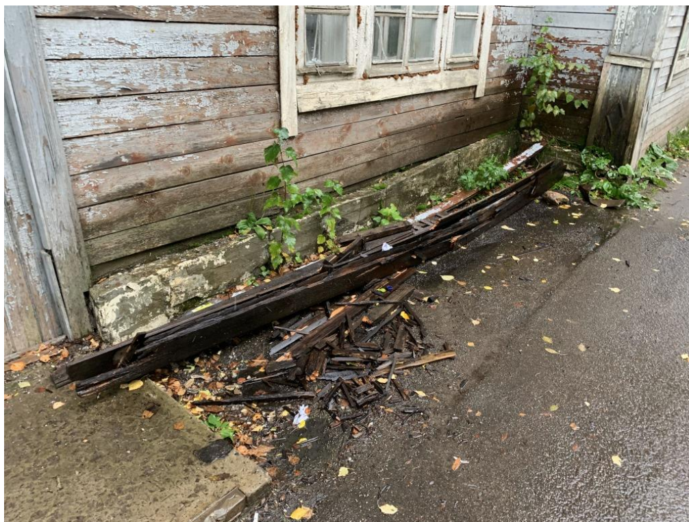
Фото 6. Цоколь главного фасада в центральной часть, обрушение подшивки карниза
