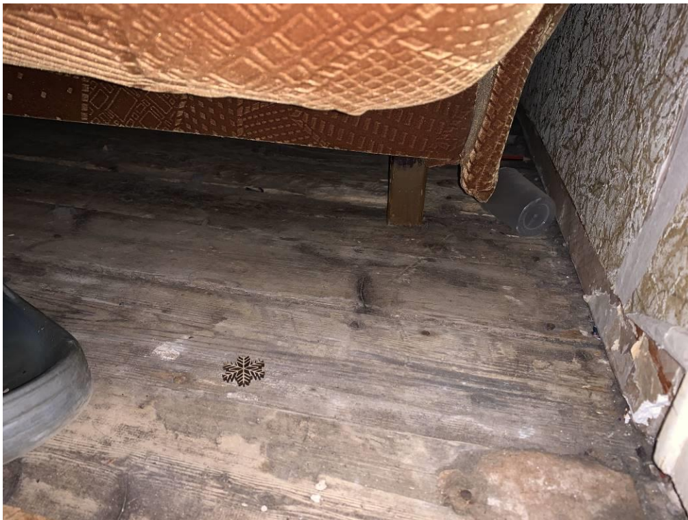
Фото 79. В квартире №5 в пом. Жилая комната уклон пола, доски рассохлись
