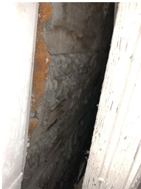
Фото 1.3.3.2. Межвенцовый утеплитель наружной стены
