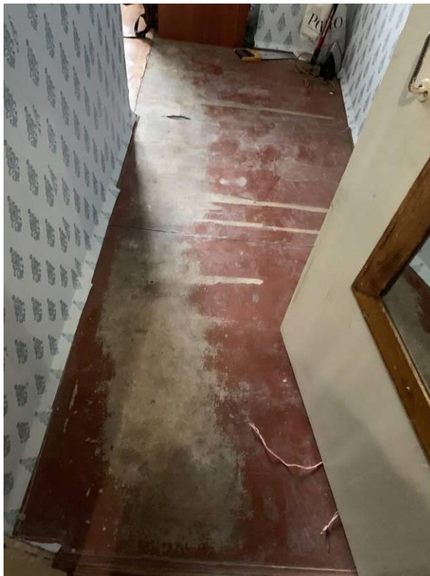
Фото 83. Истертость покрытия полов в квартире №17 в ходовых местах
