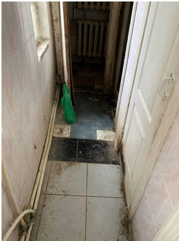
Фото 77. Уклон полов в с/у в осях 4-7/И-К
