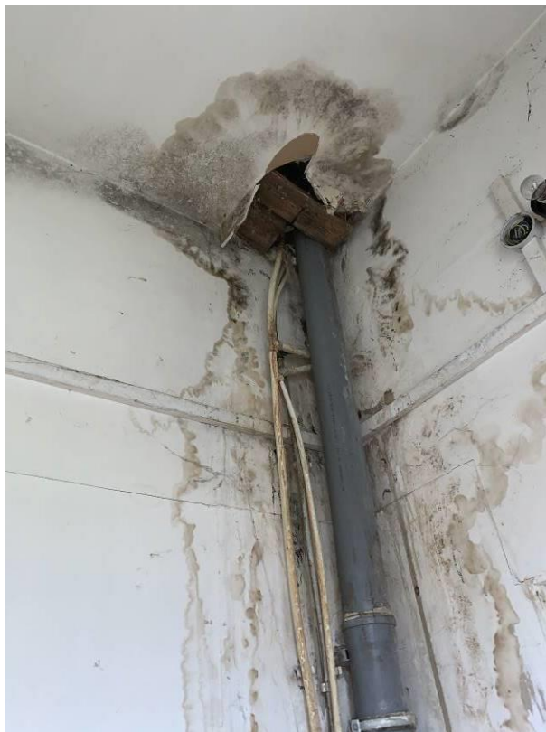
Фото 41. Перекрытие санузла в осях 4-7/И-К над 1-м этажом. Следы систематических протечек на потолке.
