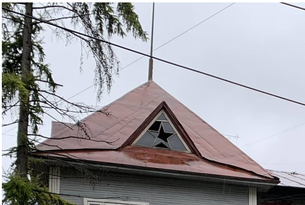
Фото 74. Разбито остекление пятиконечной звезды в осях 2-3/А
