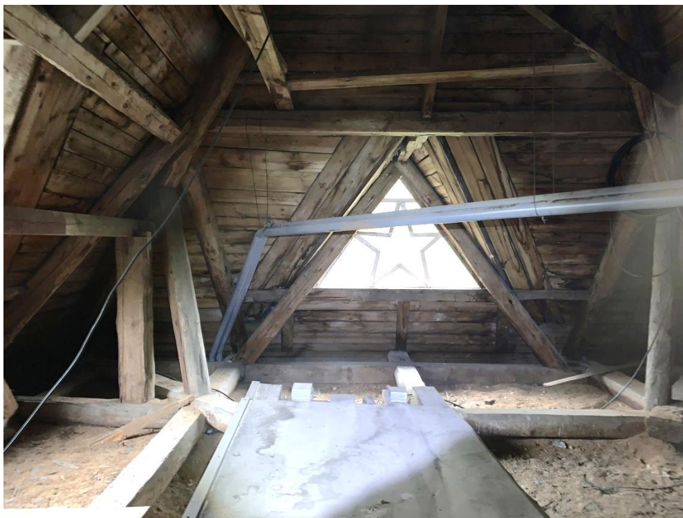
Фото 1.3.5.3 Общий вид конструкций пирамидальной крыши (колпака)
