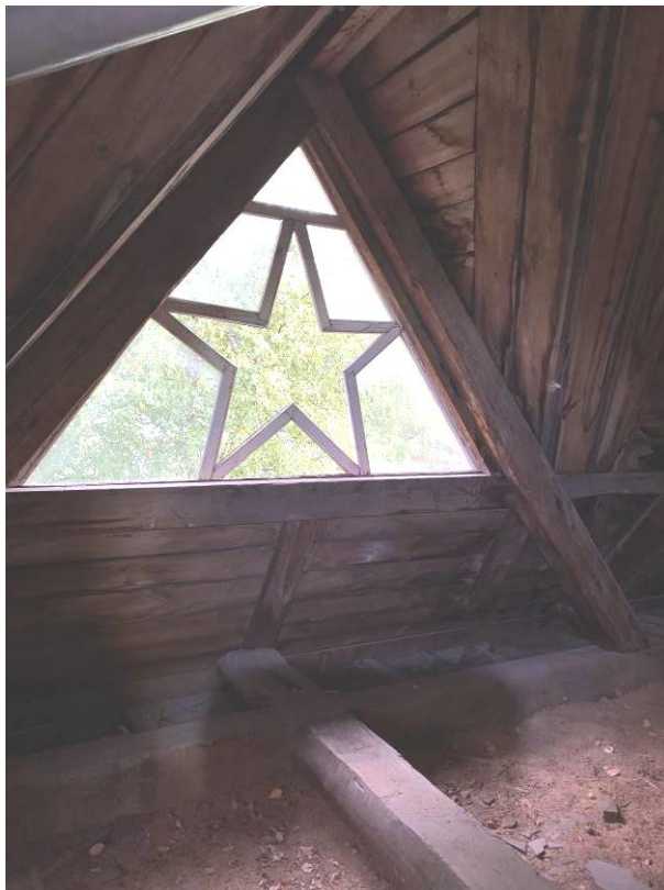
Фото 75. Разбито остекление пятиконечной звезды в осях 1/В-Б
