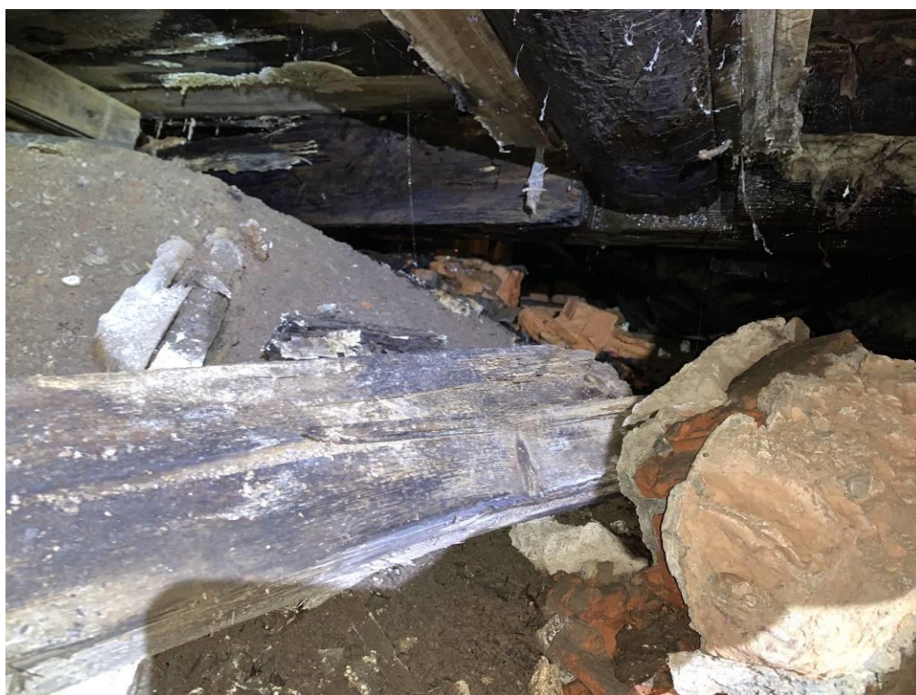
Фото 24. Нижние венцы сруба в осях 4-7/И
