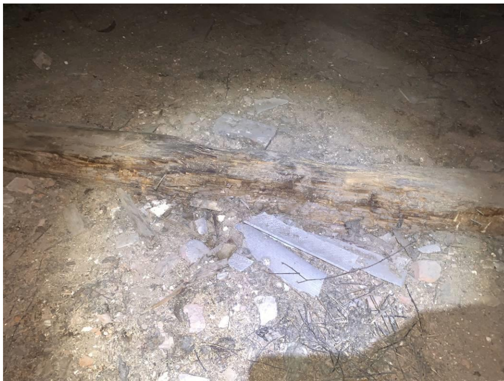
Фото 59. Брус внутренней стены разохся вследствие периодических замачиваний/высыханий в осях 6-7/Б-В
